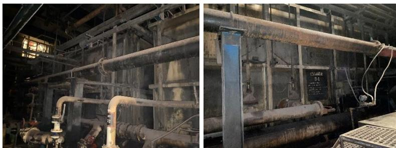
Fig. 17: Diseño original de estanques de soluble con dos secciones (Lado limpio y lado sucio)
