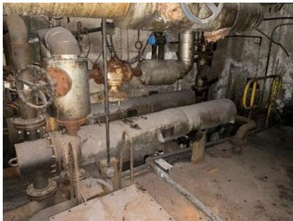
Fig. 14: Intercambiadores de calor
