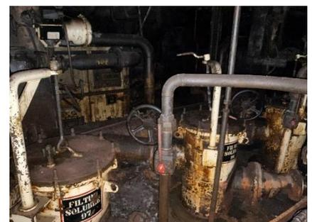
Fig. 23: Estanque de retorno, filtros de sumidero, bombas de retorno 1-2-3 (7200 Lts./min) y bombas de retorno 4-5 (2800 Lts./min.)
