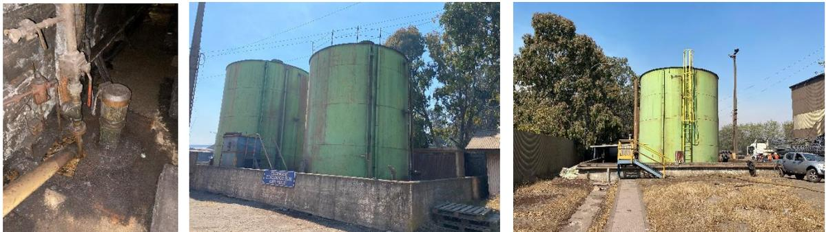
Fig. 45: Bomba de foso y estanques ecológicos Norte (230 Mt<sup>3</sup>.) y Sur (145 Mt<sup>3</sup>.).
