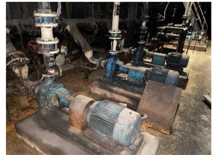
Fig. 16: Bombas de recirculación de filtros magnéticos
