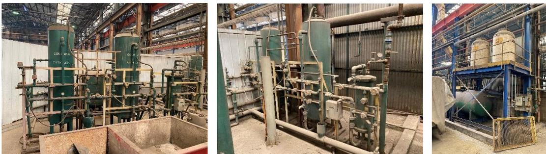
Fig. 26: Planta de tratamiento de agua des-mineralizadora y estanque de insumos (Soda caustica y Ácido Clorhídrico) y almacenamiento de agua destilada.
