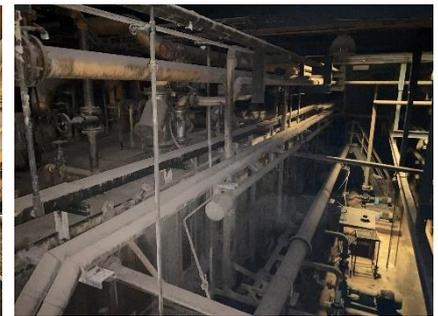
Fig. 12: Nivel inferior Roll Coolant, estanque y bombas
