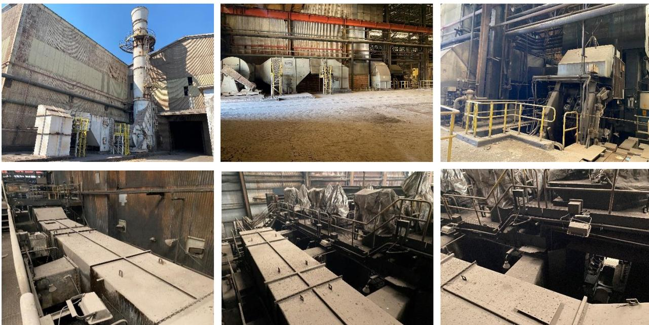
Fig. 27: Sistema de extracción de humos (Vapores) del laminador (Filtros, extractor y decantadores)
