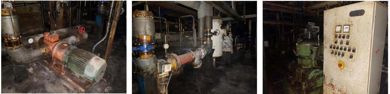
Fig. 28: Bomba impulsora, acumulador, filtro y separator westfalia
