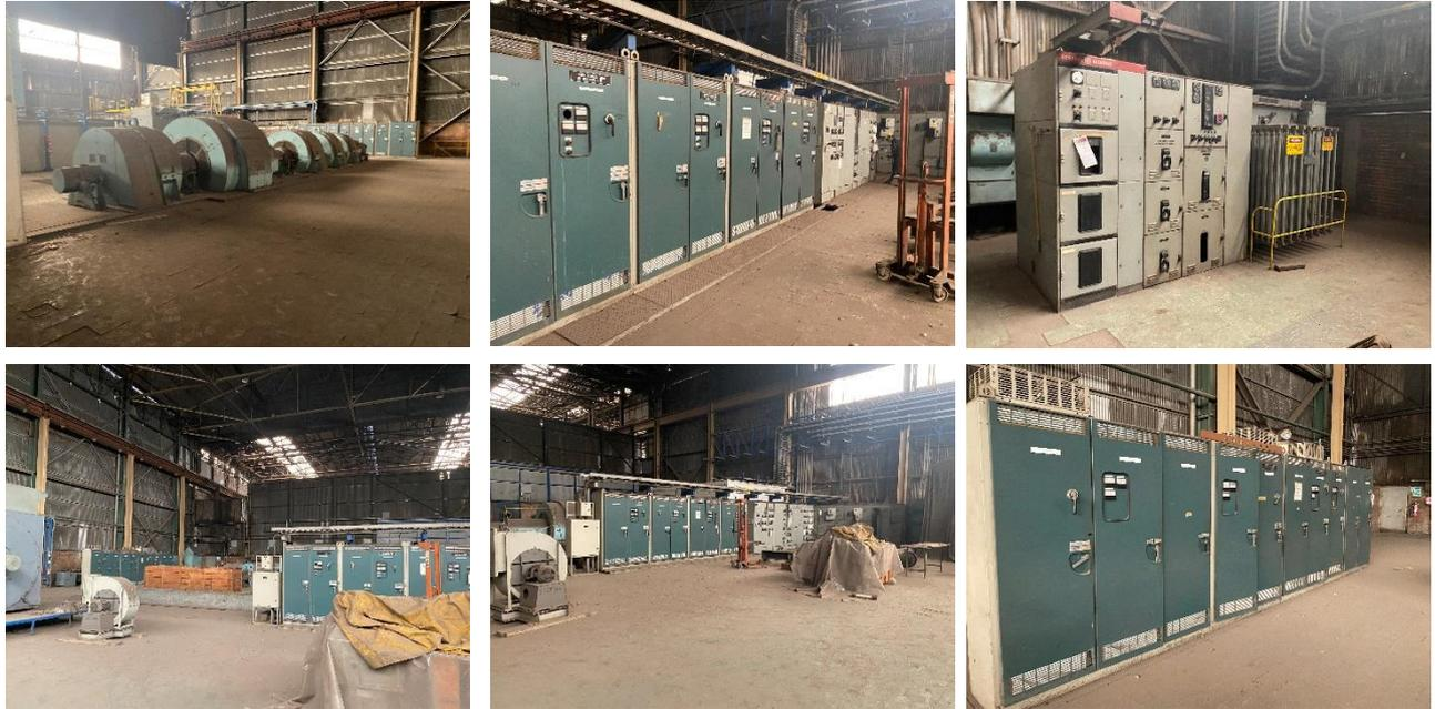
Fig. 51: Equipos de sala motores (Tren de motores, gabinetes, celdas switchgear, trafos y ventiladores)
